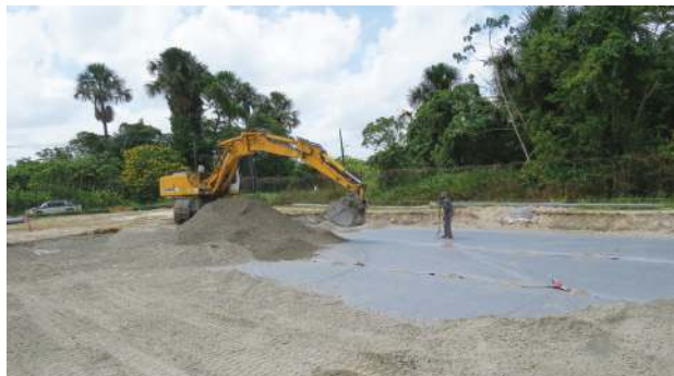
Travaux sur la plateforme de stockage au port de commerce
