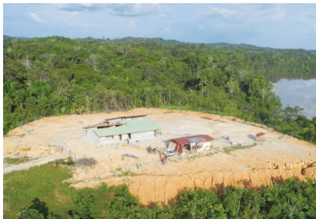
Centrale de Providence en cours de construction - commune d'Apatou
